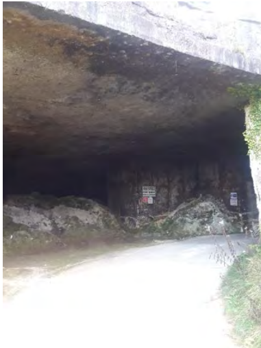
Entrée de la carrière
