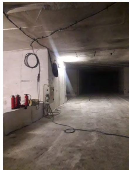
Chantier Zone baudrie
