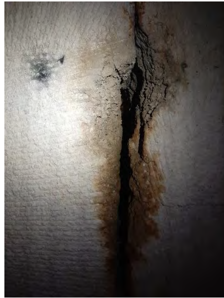
Figure 8 : Fissuration géologique avec développement de karst
